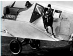
Bereits 1915 stellte Hugo Junkers das erste Ganzmetallflugzeug vor. Die Oberfläche aus Aluminiumwellblech wurde zum Markenzeichen der Junkers. Vier bis sechs Passagiere konnten jetzt geschützt in einer geschlossenen Kabine reisen.
